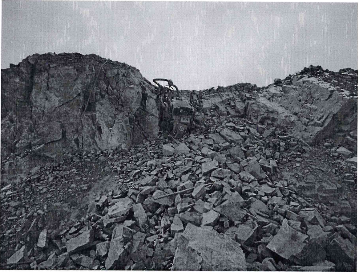
图 1: 事故发生点 (2#上山道路 1.4km 处)
