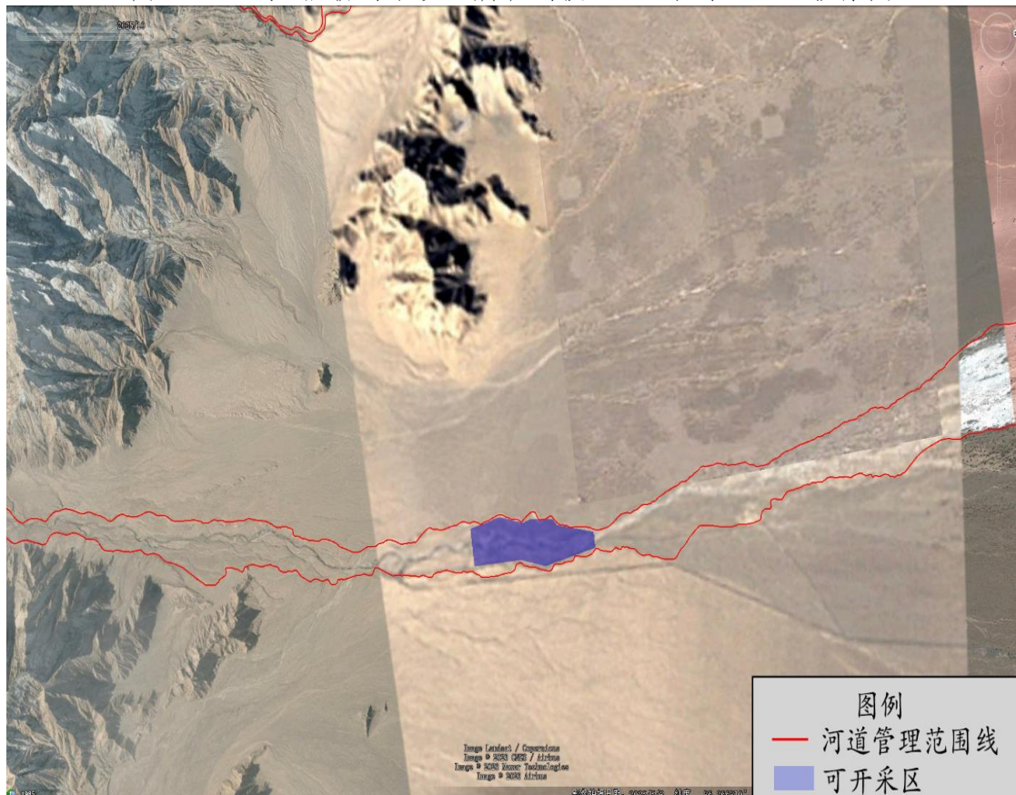
图 4.2-12 大格勒河采砂区所在河段 2025 年河道卫星影像图
